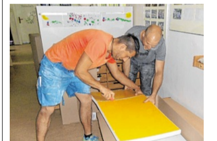
Die Eltern bringen Absorberplatten im Turnraum und im Flur an.
